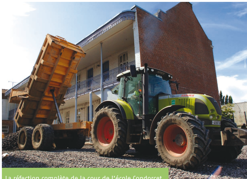
La réfection complète de la cour de l'école Condorcet.
